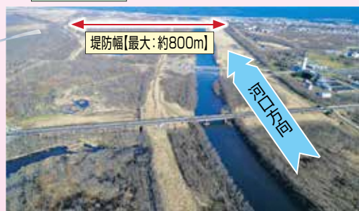
サーモン橋上空からの標津川周辺の俯瞰写真
