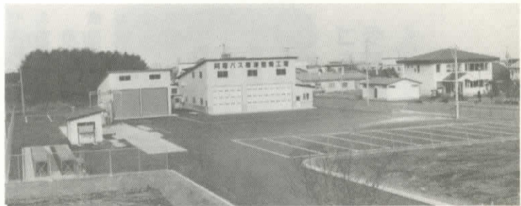
バス整備工場などが完成しました
