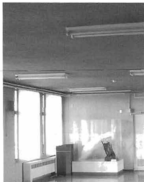
除去改修されるアスベスト天井
