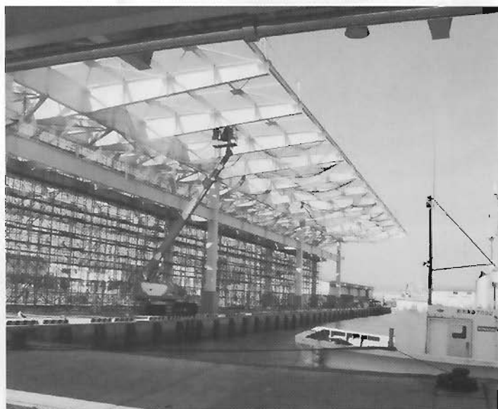
標津港屋根付岸壁工事
