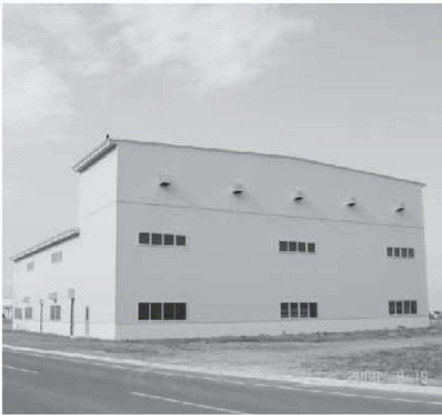
標津港の取水排水施設
