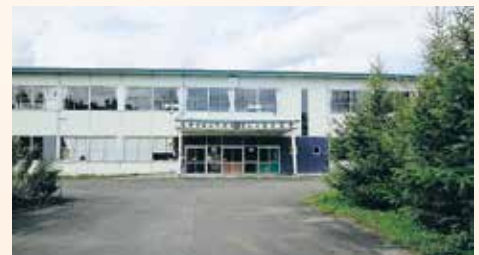
平成24年3月31日廃校の 古多糠小中学校校舎
