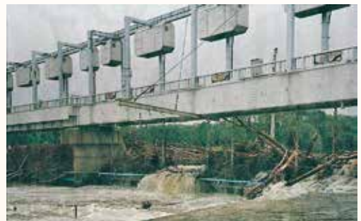
■ 標津川の捕獲用の柵にたまった流木(9月3日)
