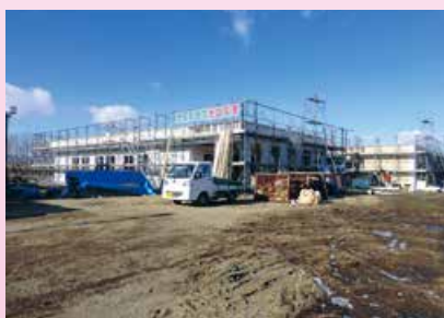
建設中の高齢者福祉施設『陽だまり』
