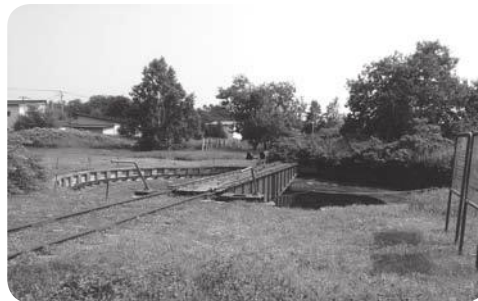
根室標津駅の転車台
