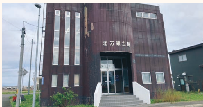
建て替えが検討されている北方領土館
