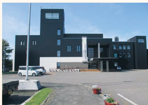
人間空間に冷房設備が整備されていない役場庁舎
