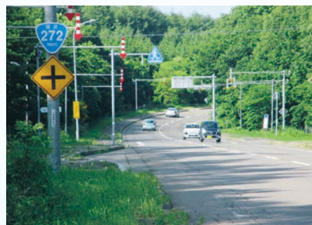
国道272号線(町道川北茶志骨線との交差点付近)の様相
