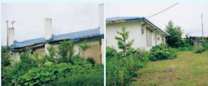
解体前提の公営住宅の現況（文中の団地とは無関係）
