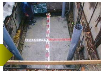
②基礎コン～支柱設置
